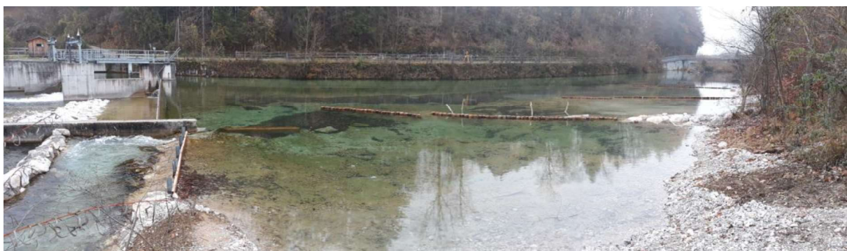
Abbildung 113: Geschiebeabweiser an der Alm / Österreich
