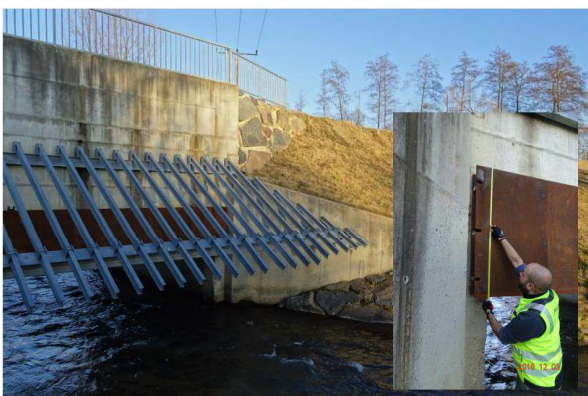
Prinzip Drosselbauwerk (Zulauf) – Ungesteuert
